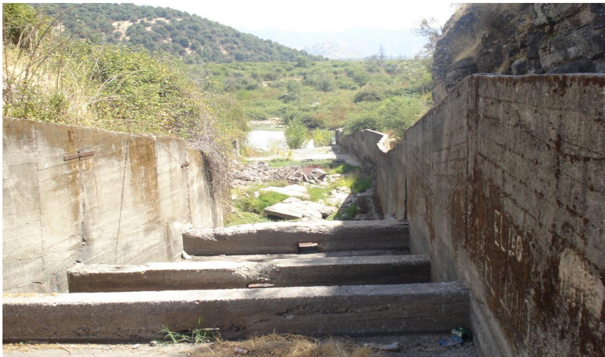
Foto 7. Vertedero de seguridad sin daño.
