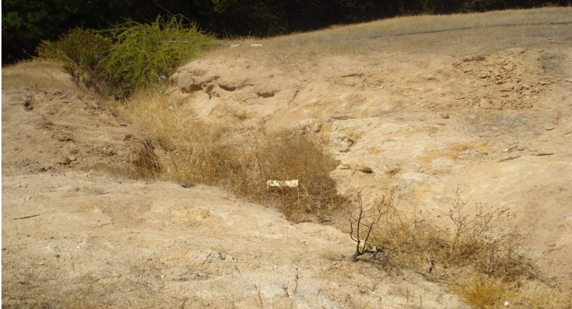
Foto 5. Vertedero de seguridad sin daños.
