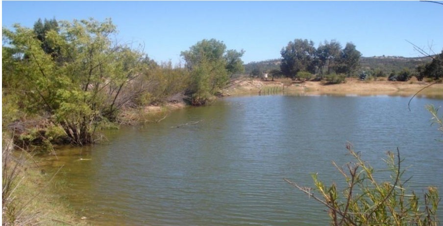
Foto 2. Coronamiento y talud interno.
