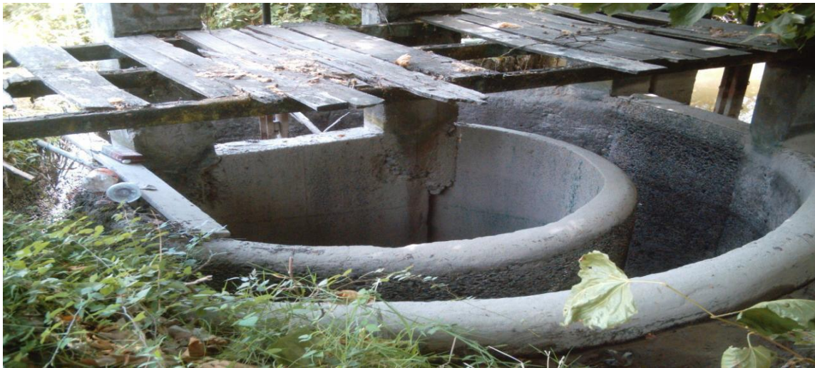
Foto 3. Obra de evacuación y entrega.
