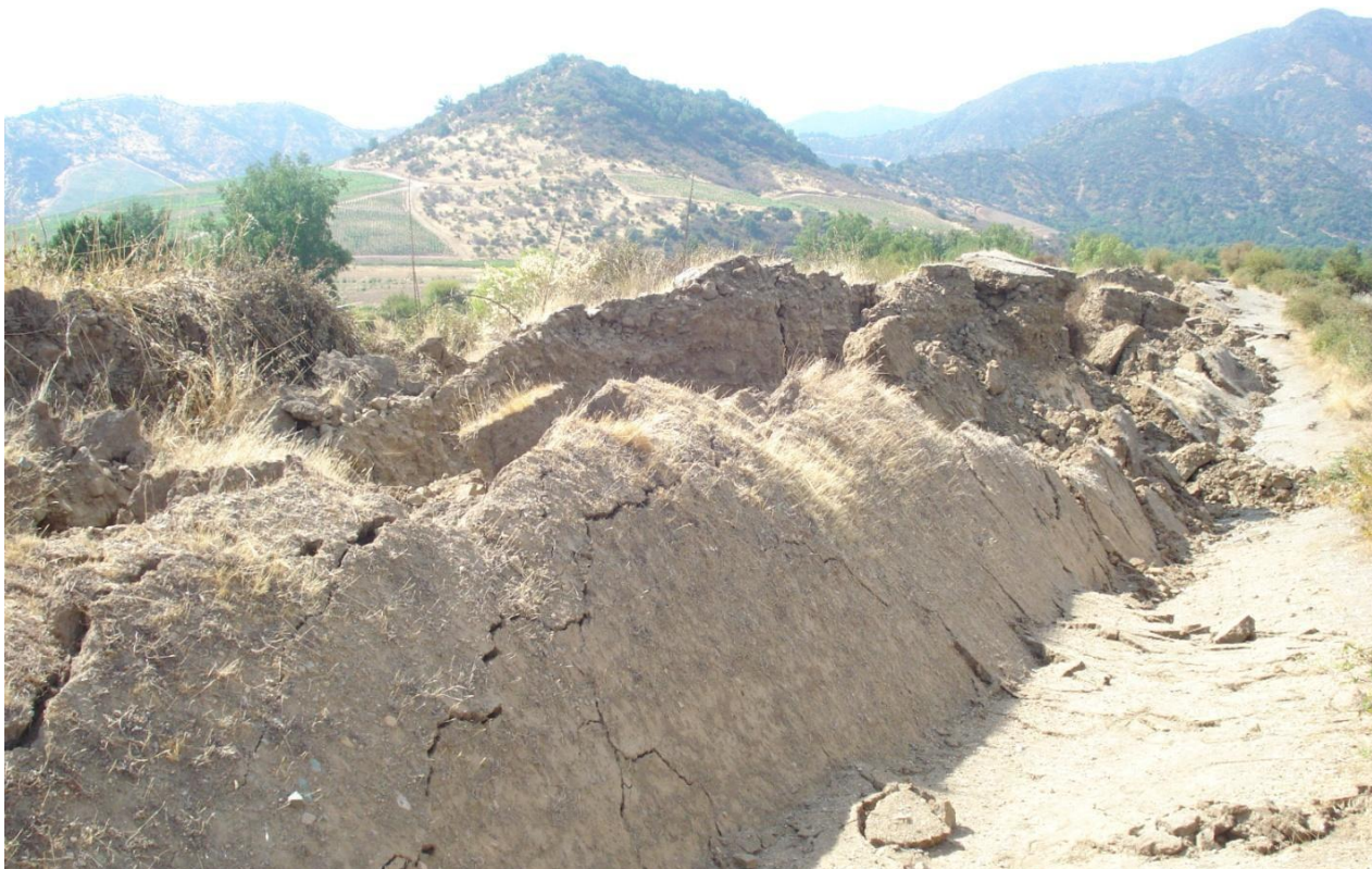
Foto 3. Destrucción del Muro después del terremoto.
