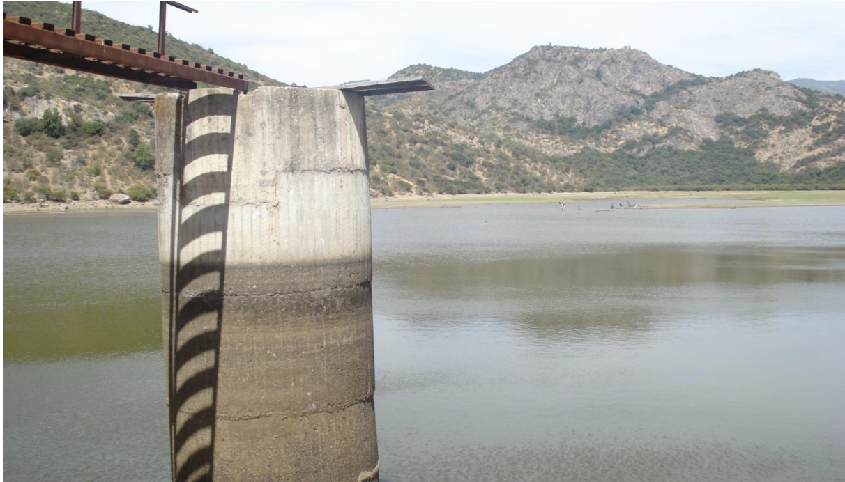
Foto 6. Torre de toma sin daños.
