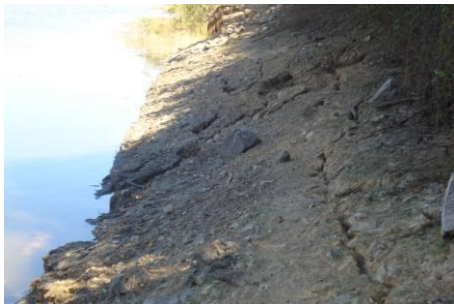
Foto 2. Talud interno se presenta con desplazamiento y grietas.
