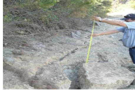
Fotos 3. Talud interno presenta grietas de 0,4 metros a 1,2 metros de profundidad en todo el largo del Talud.
