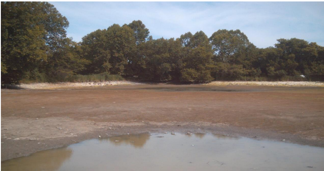
Foto 1. Volumen acumulado y talud interior.
