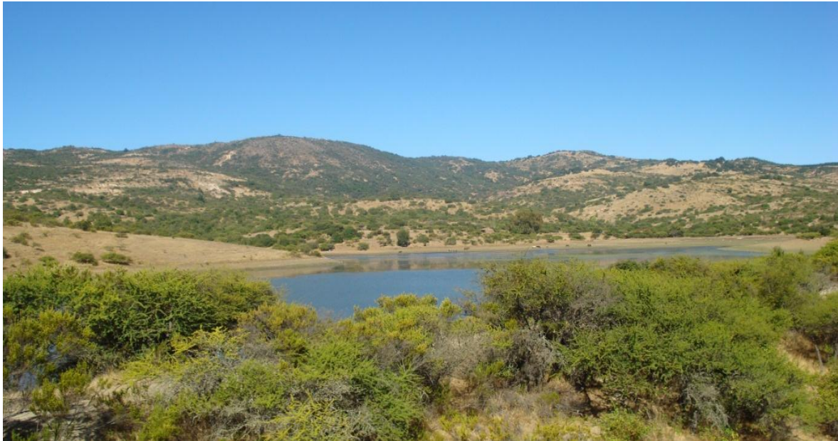
Foto 1. Talud externo y cuenca aportante.
