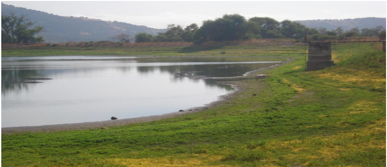
Foto 1. Talud interior y cuenca aportante
