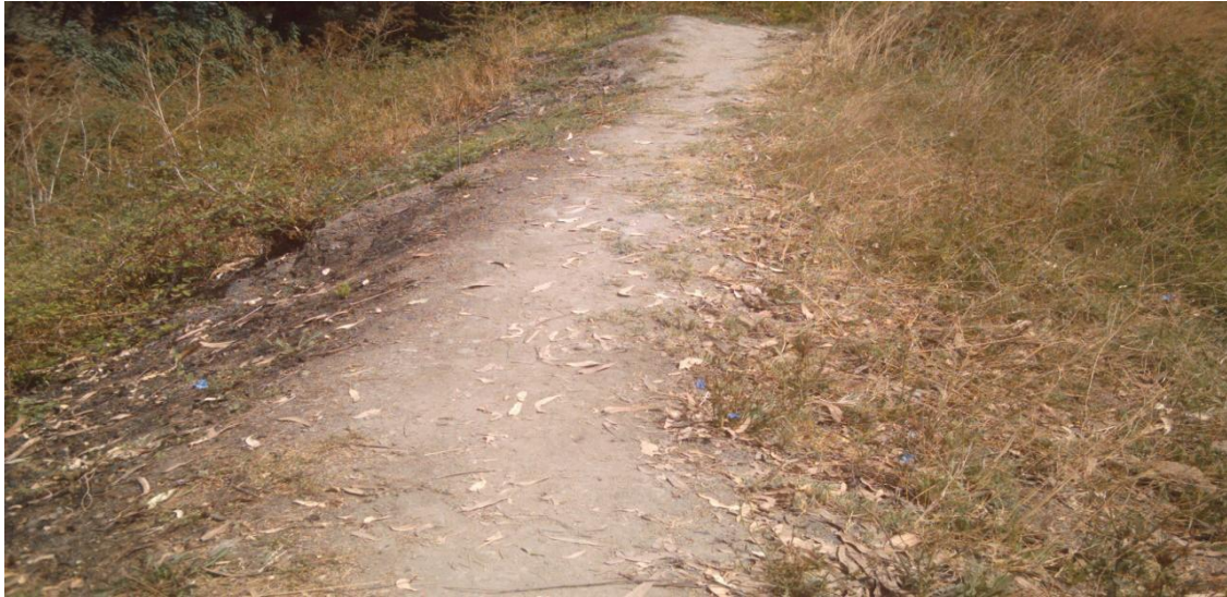
Foto 2. Coronamiento del muro sin daños.
