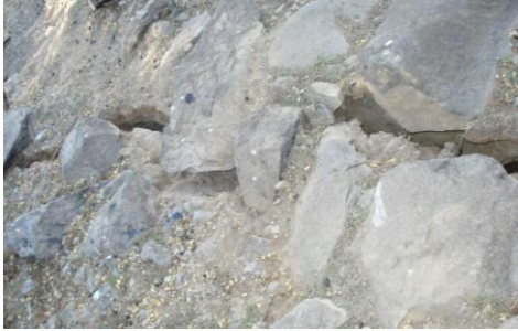
Fotos 3. Talud interno presenta grietas de 0,4 metros a 1,2 metros de profundidad en todo el largo del Talud.
