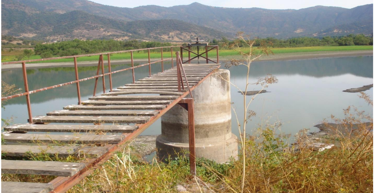
Foto 2. Torre de Toma sin daños, embalse y cuenca aportante.
