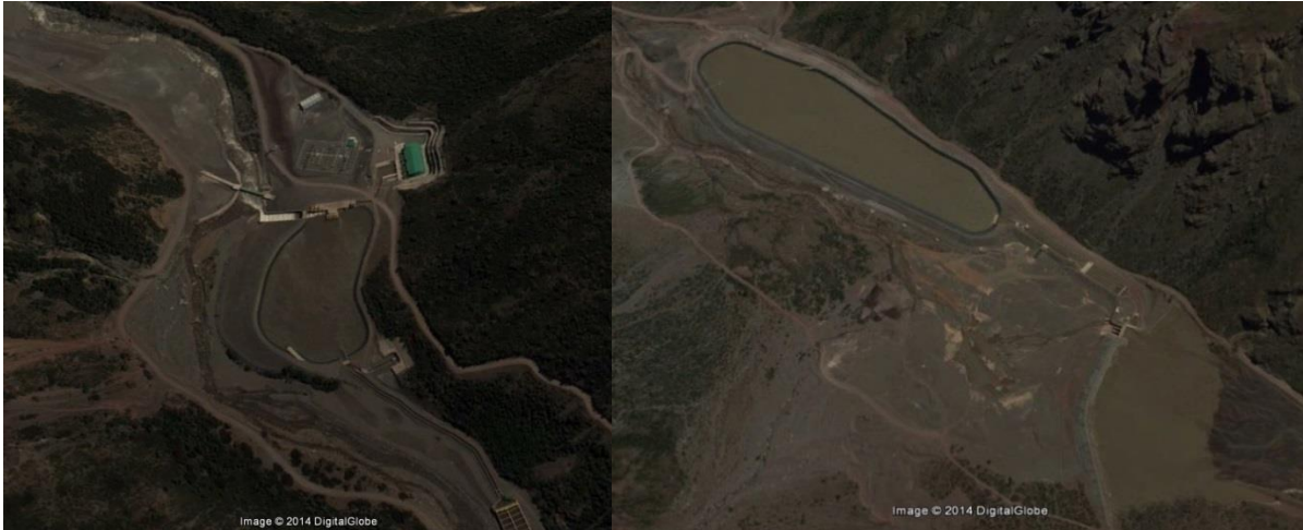
Ponds Central Hidroeléctrica La Confluencia y La Higuera. (Fuente: Google Maps, 2014)
