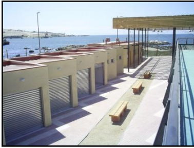
Figura N°44. Mejoramiento Puerto pesquero de Caldera (Boxes), Comuna de Caldera
