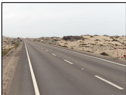
Figura N°48. Ruta 5 Norte, Sector Vallenar – La Serena (Situación Actual)
